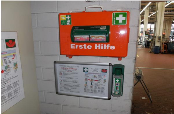
Im Bereich Erste Hilfe
